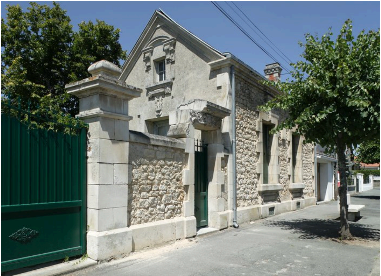
Maison 16, boulevard de l'Aumônerie (vers 1900).
