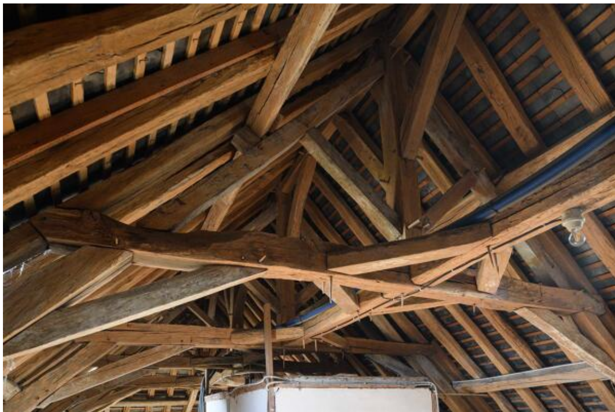
Vue d'ensemble des fermes de la charpente, comble du presbytère.
