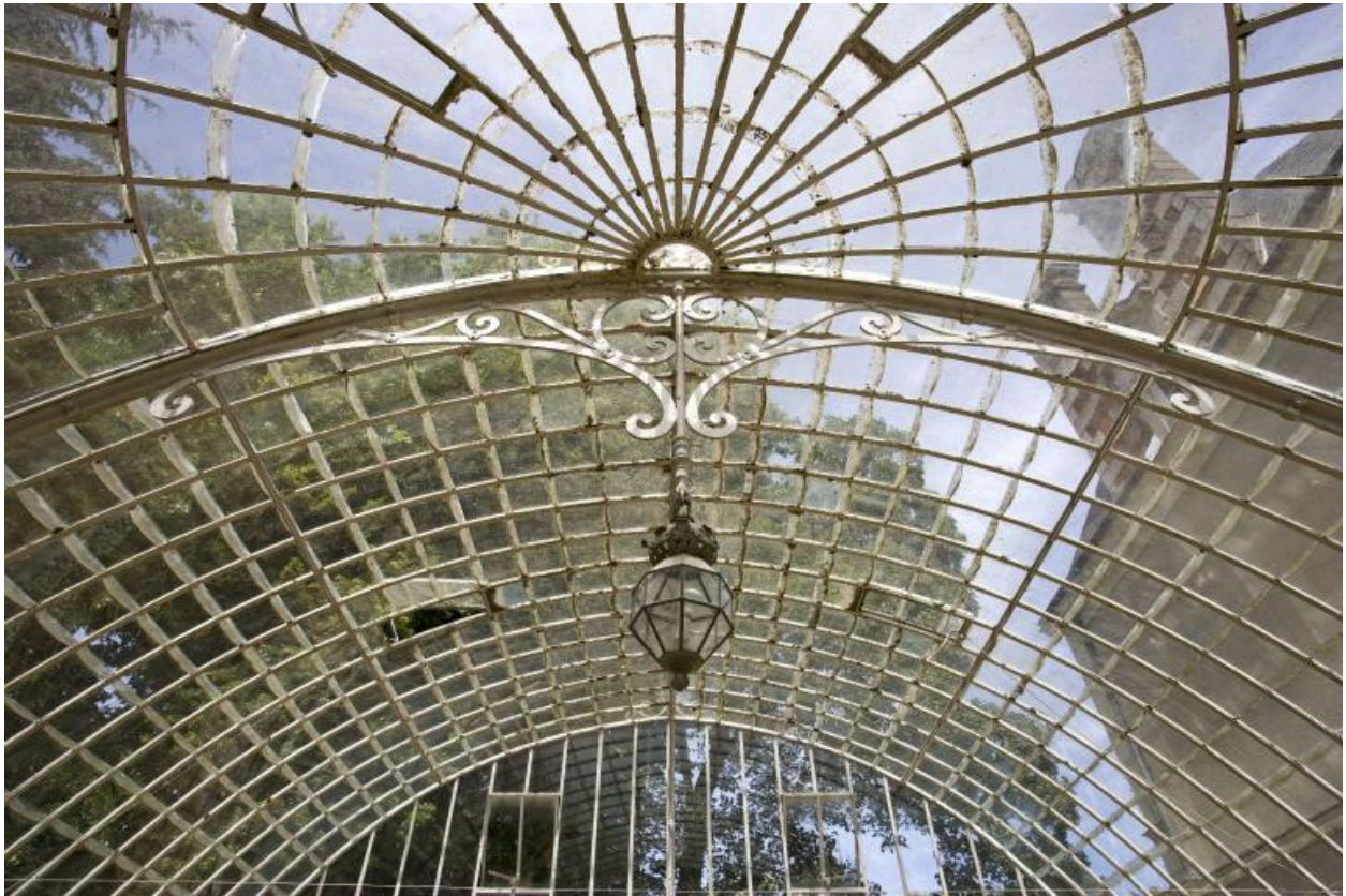
La serre : détail de ferronnerie.
