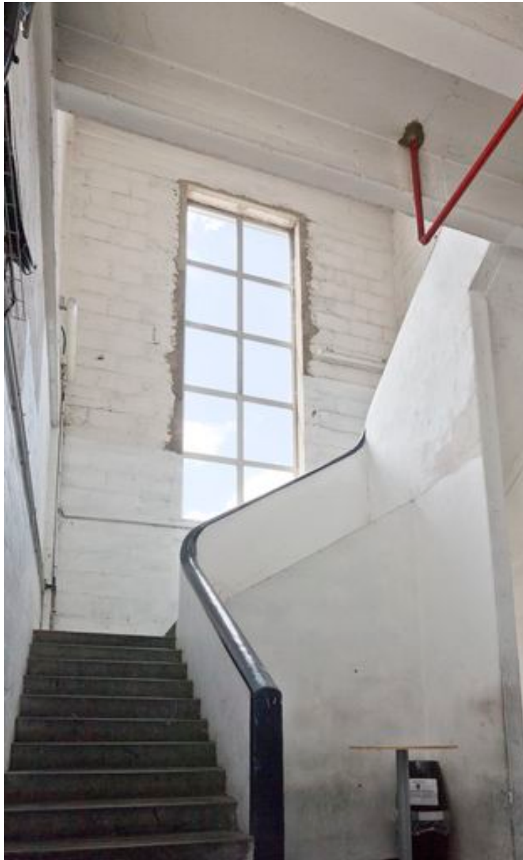
Escalier du bâtiment de fabrication et de broyage.
