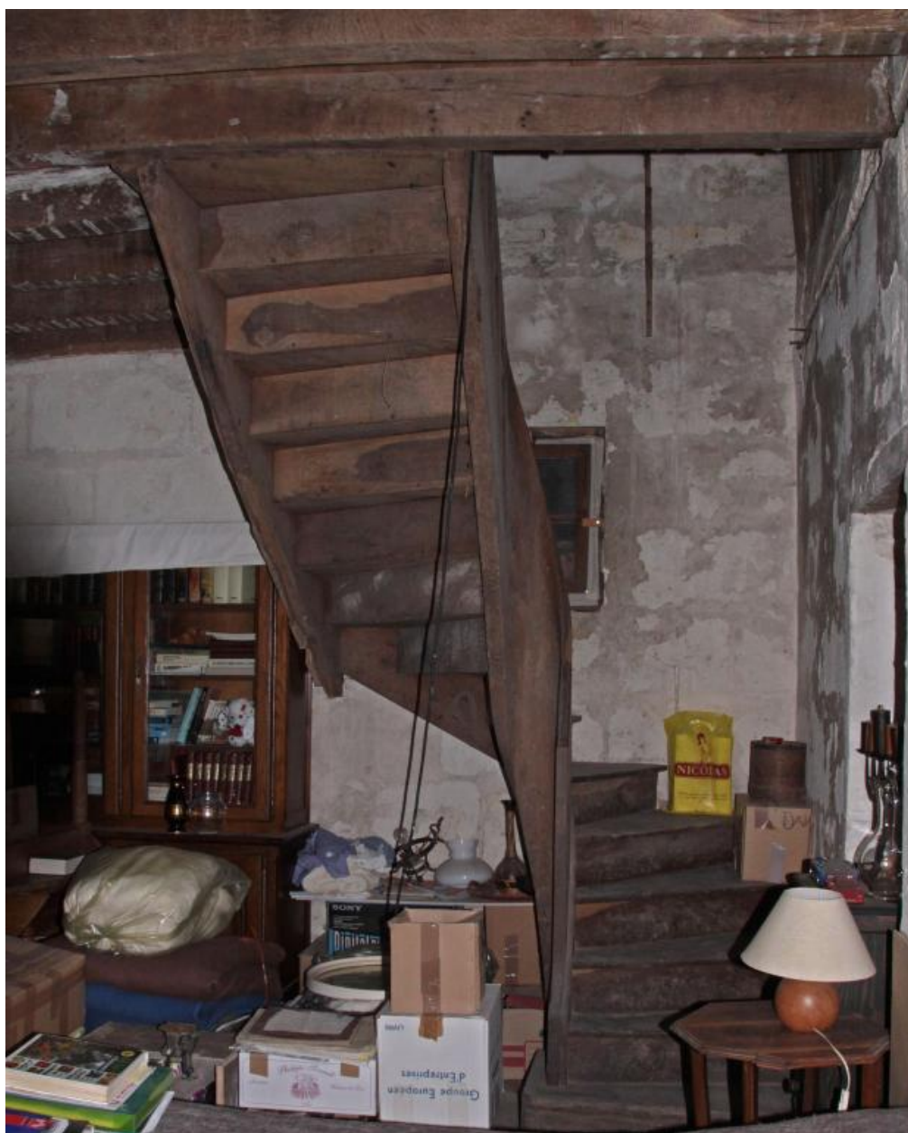
Maison, pièce ouest : escalier tournant en bois menant au comble.
