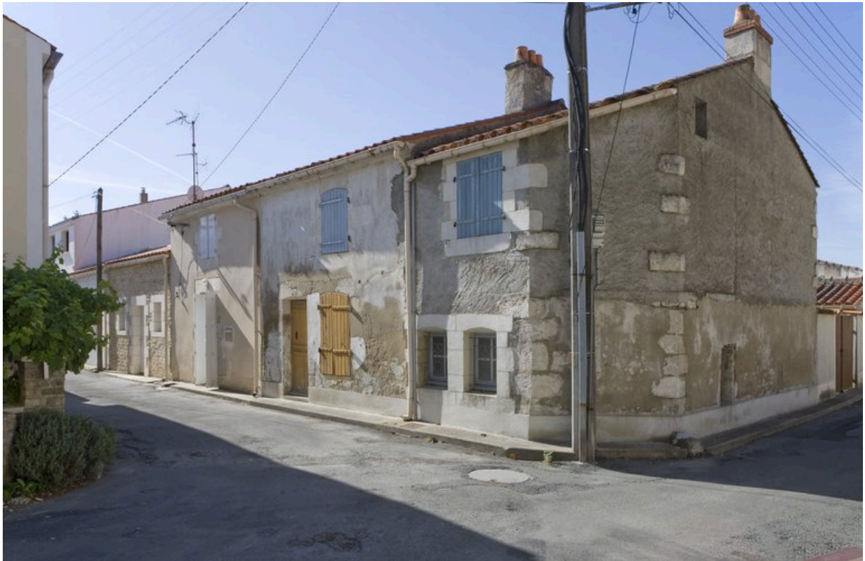
Quartier de la Vase : maisons anciennes, 17-21 et 23, rue du Traversière.
