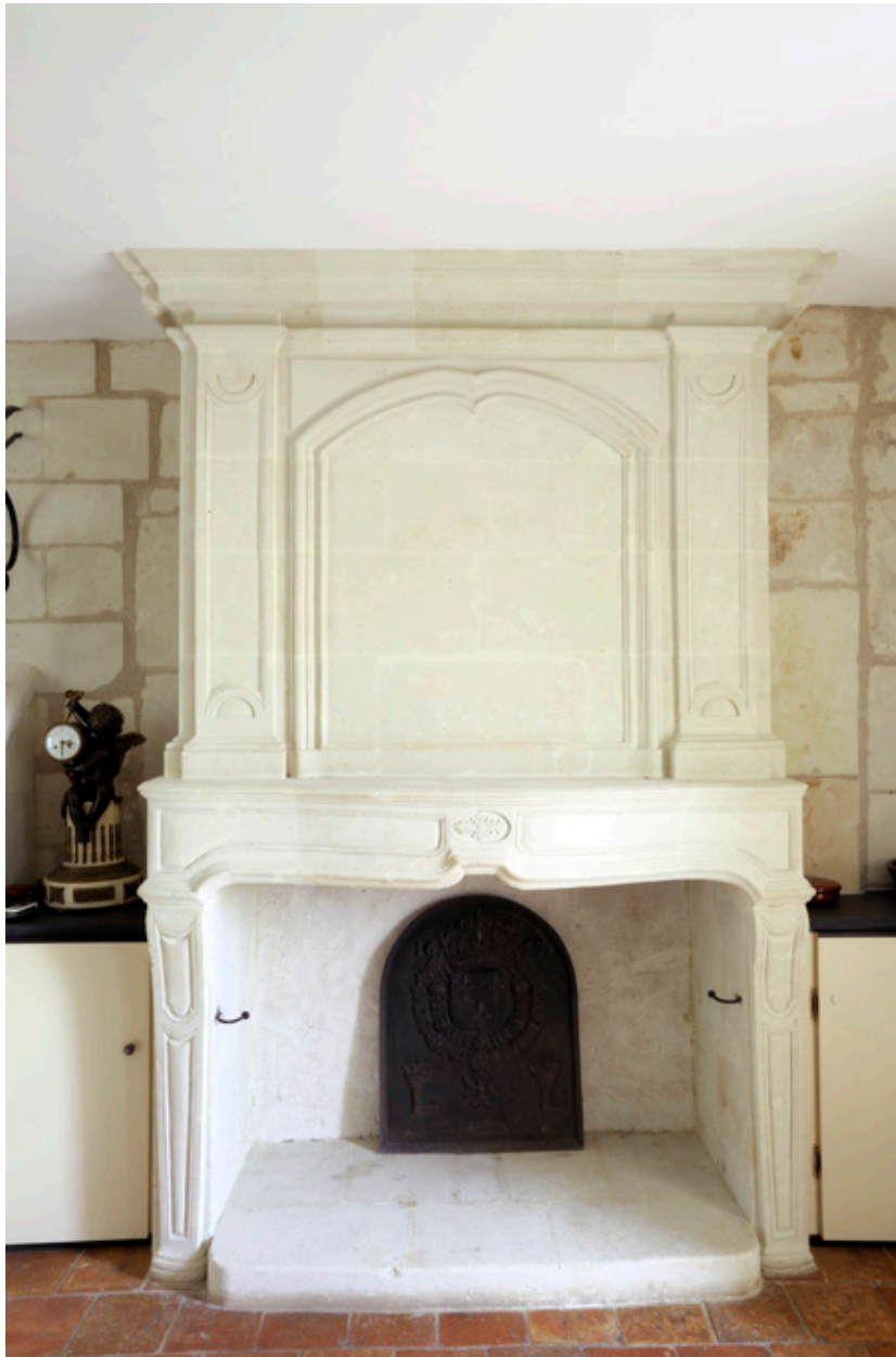
Corps est, rez-de-chaussée : cheminée du XVIIIe siècle (vue de face).
