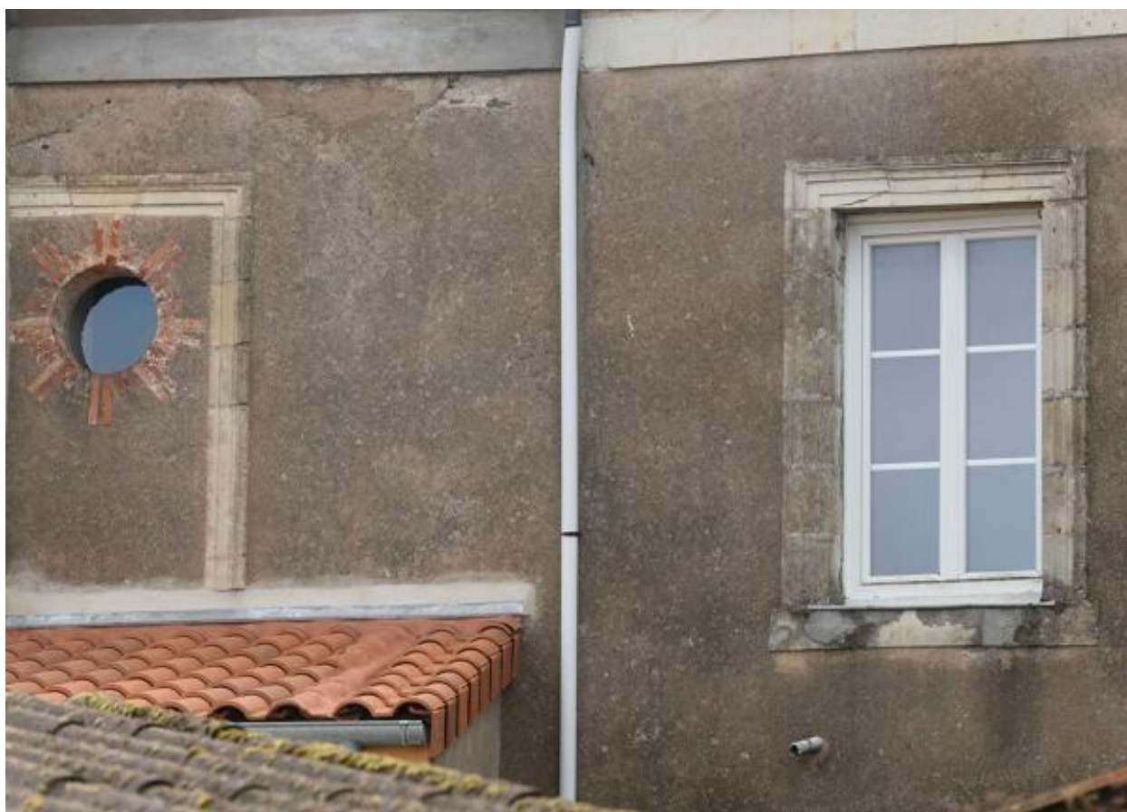
Détail de deux baies rue de l'Eglise.
