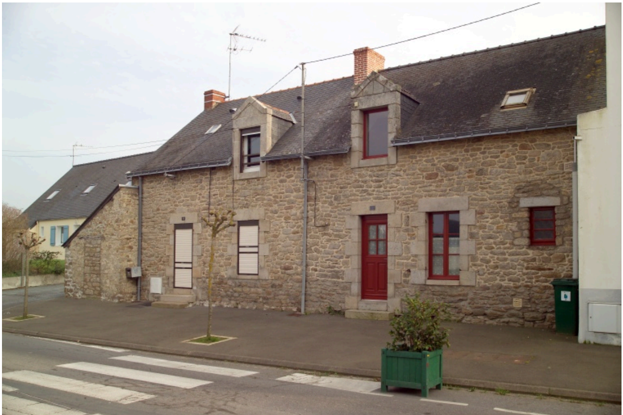
Maison jumelée de la fin du XIXe siècle dans le faubourg Saint-Armel.
