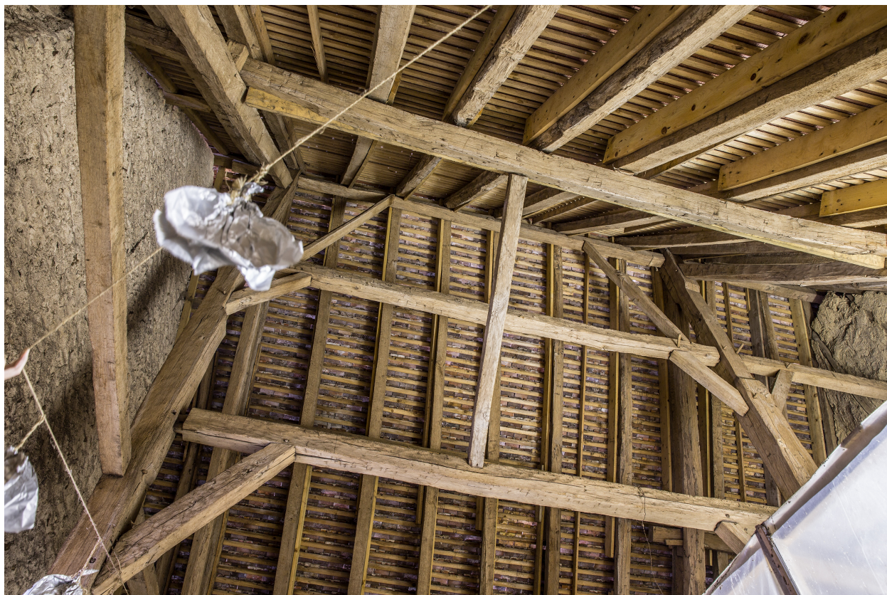
Une vue de la charpente.
