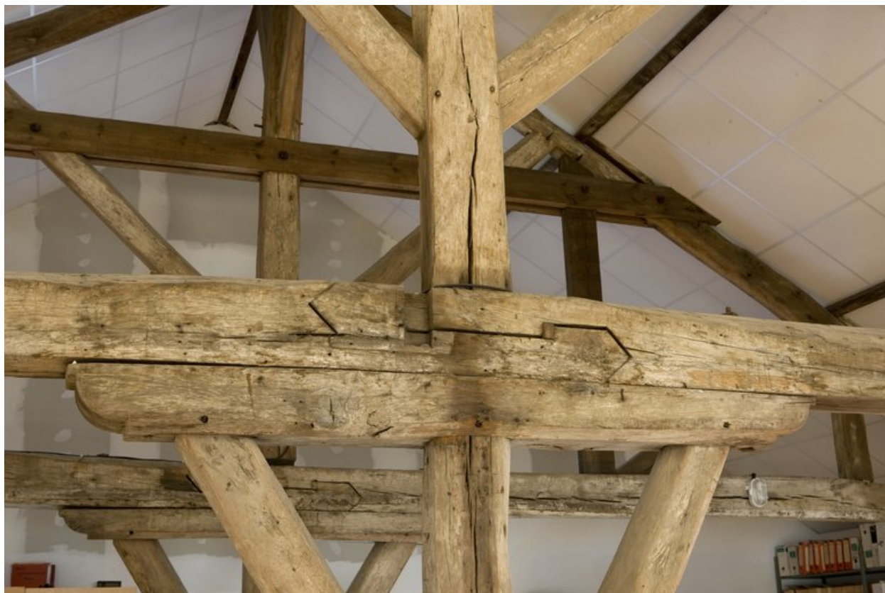
14, quai est, magasins Phelipon : détail de la charpente.
