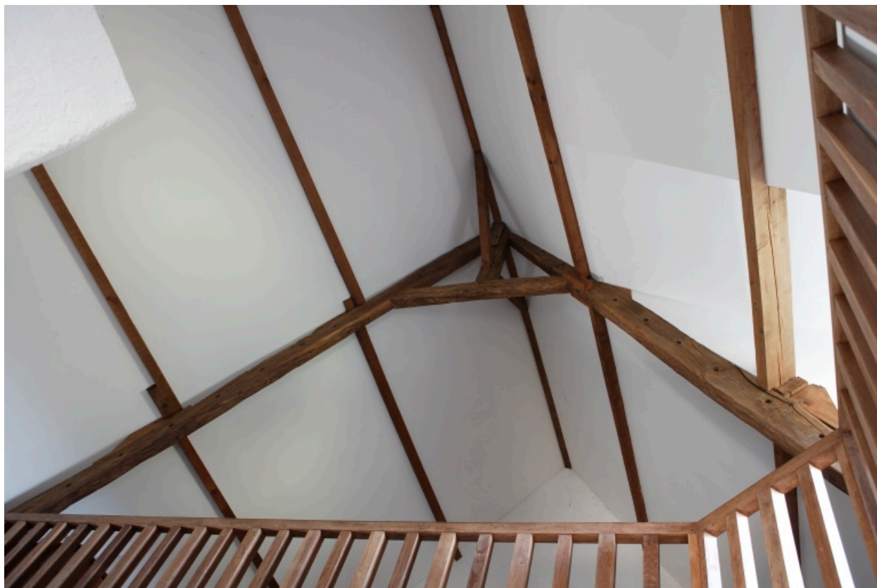
Détail d'une ferme de la charpente (logis est).
