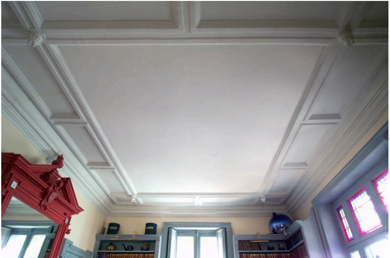
Plafond du salon ouest.
