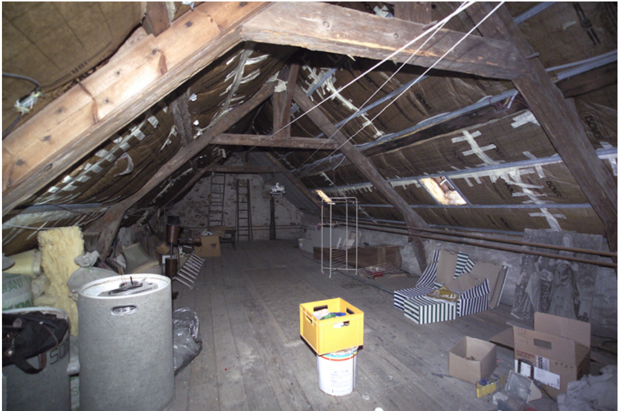
Vue de la charpente vers la Loire (n° 5).
