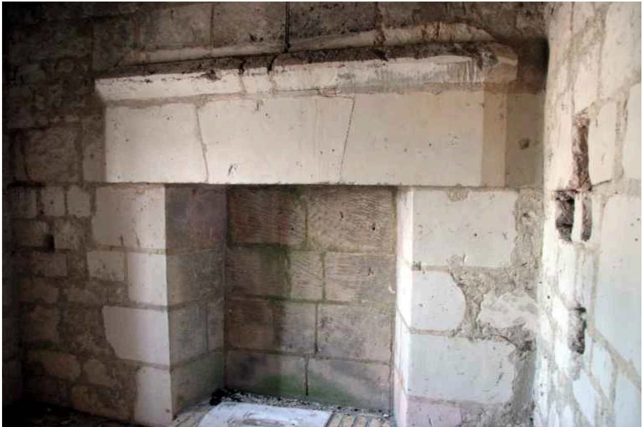
1er étage de la tour : cheminée.
