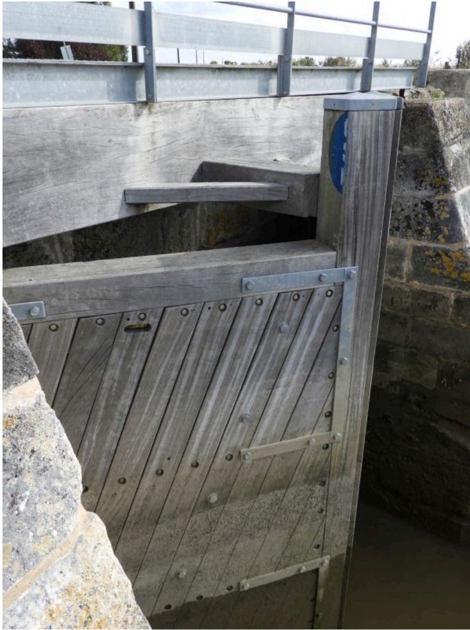
Les vantaux busqués de la porte, côté aval.
