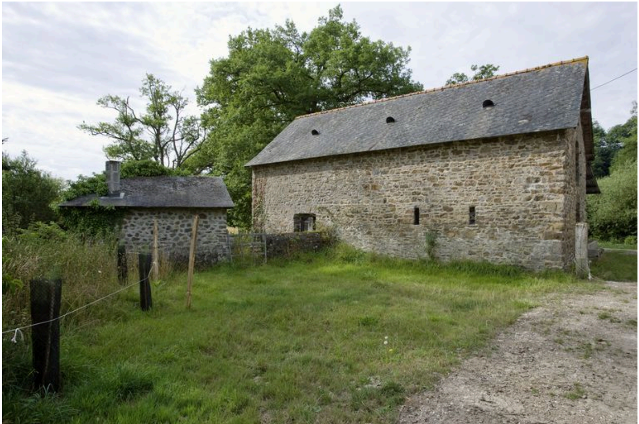
Fournil et étable édifiés sur l'ancienne motte : vue depuis le nord.
