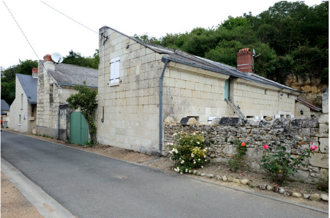
Maisons en appentis, au sud de la Haute-Rue.
