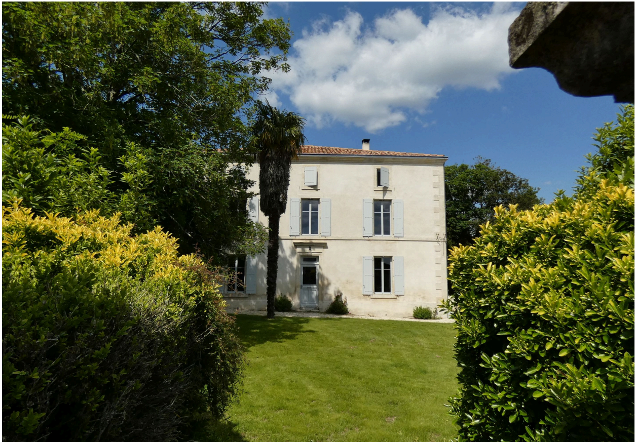
La demeure vue depuis le sud-ouest.
