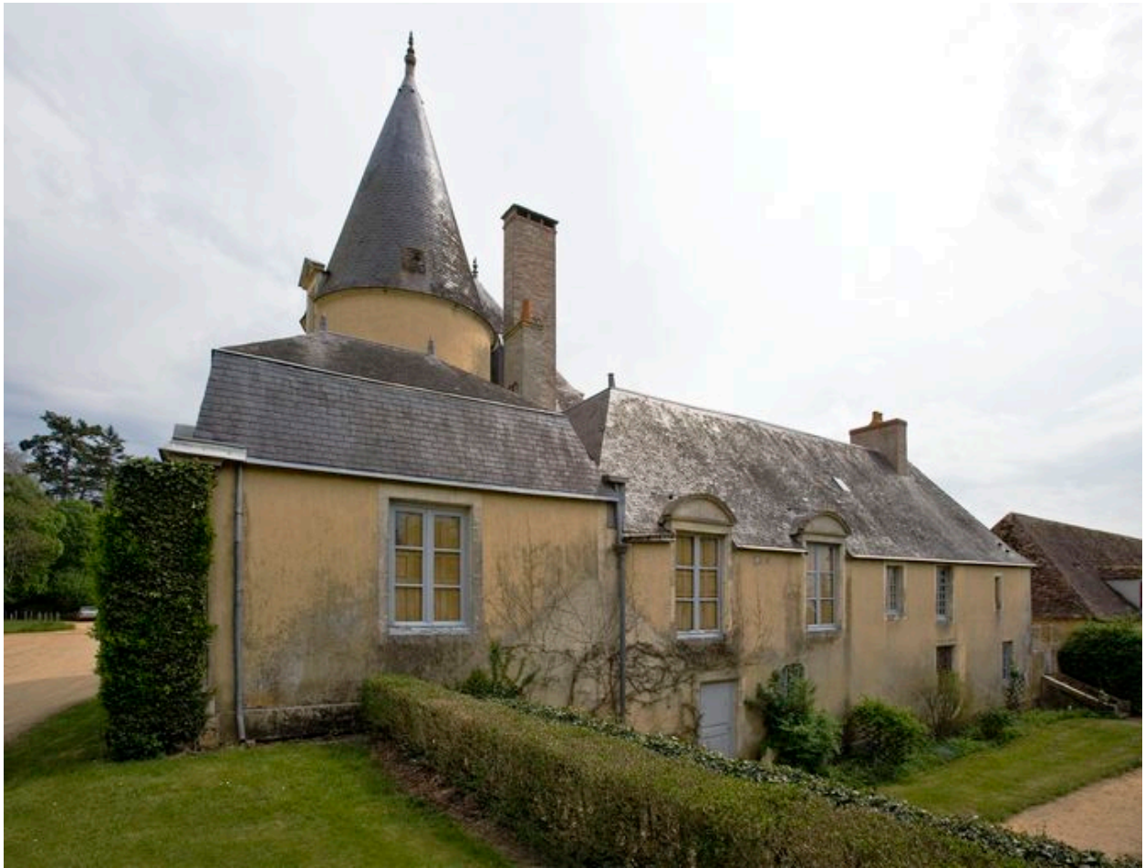
Aile ouest vue du nord-ouest
