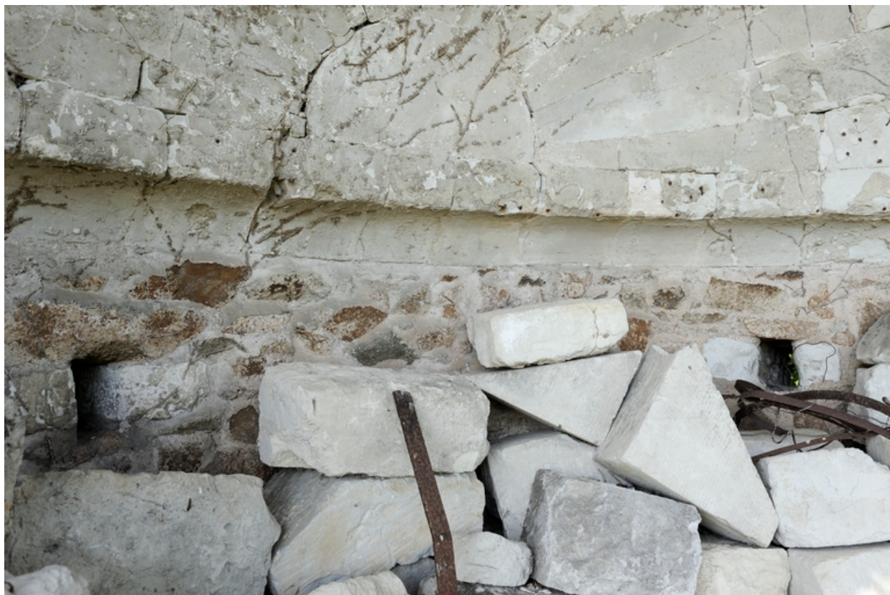
Reposoir de jardin. Détail de la maçonnerie.
