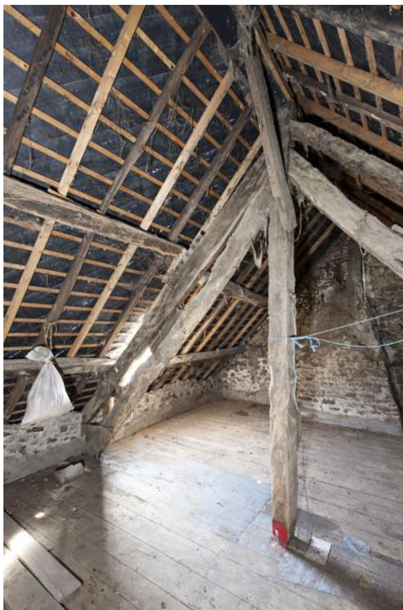
Charpente du logis nord.
