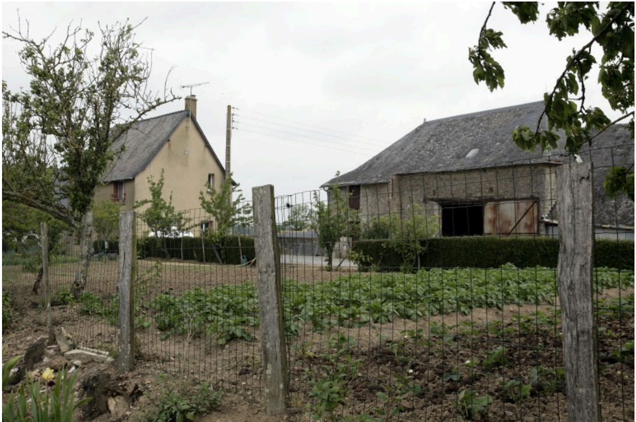
Le logis (ancien manoir?) et la remise-cave vus depuis le sud.
