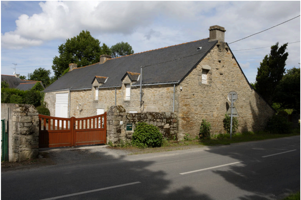
Vue de la façade sud.
