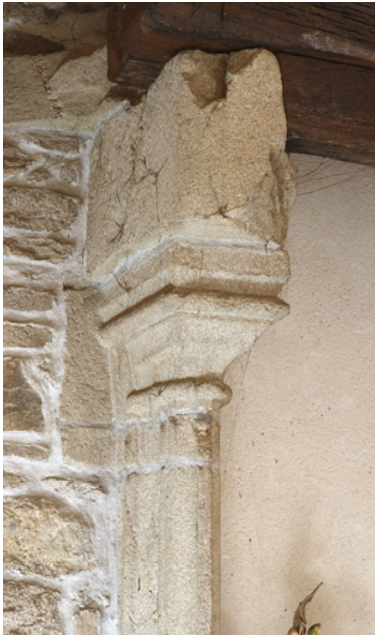
Logis. Cheminée de l'étage. Détail de la console de gauche.
