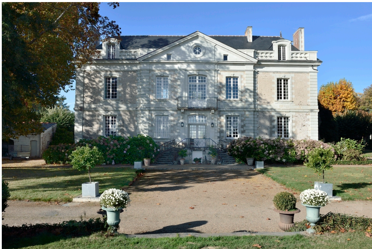
Vue de la façade est.
