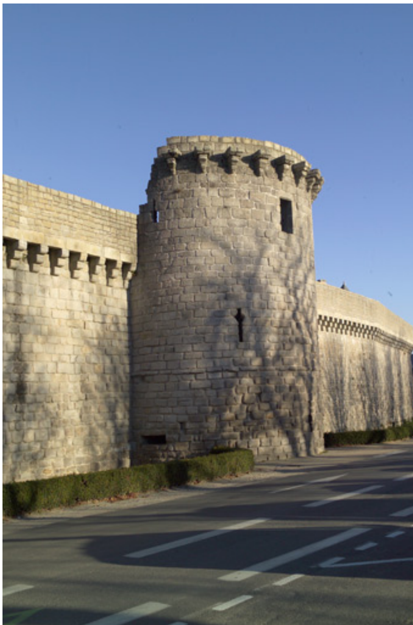
Vue générale de la tour et de l'enceinte.
