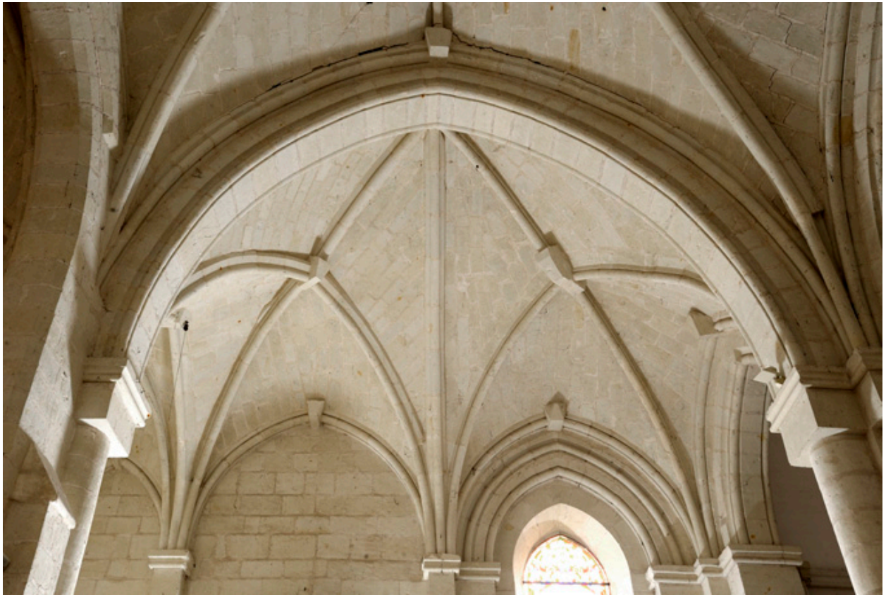
Voûtes du bras sud du transept.
