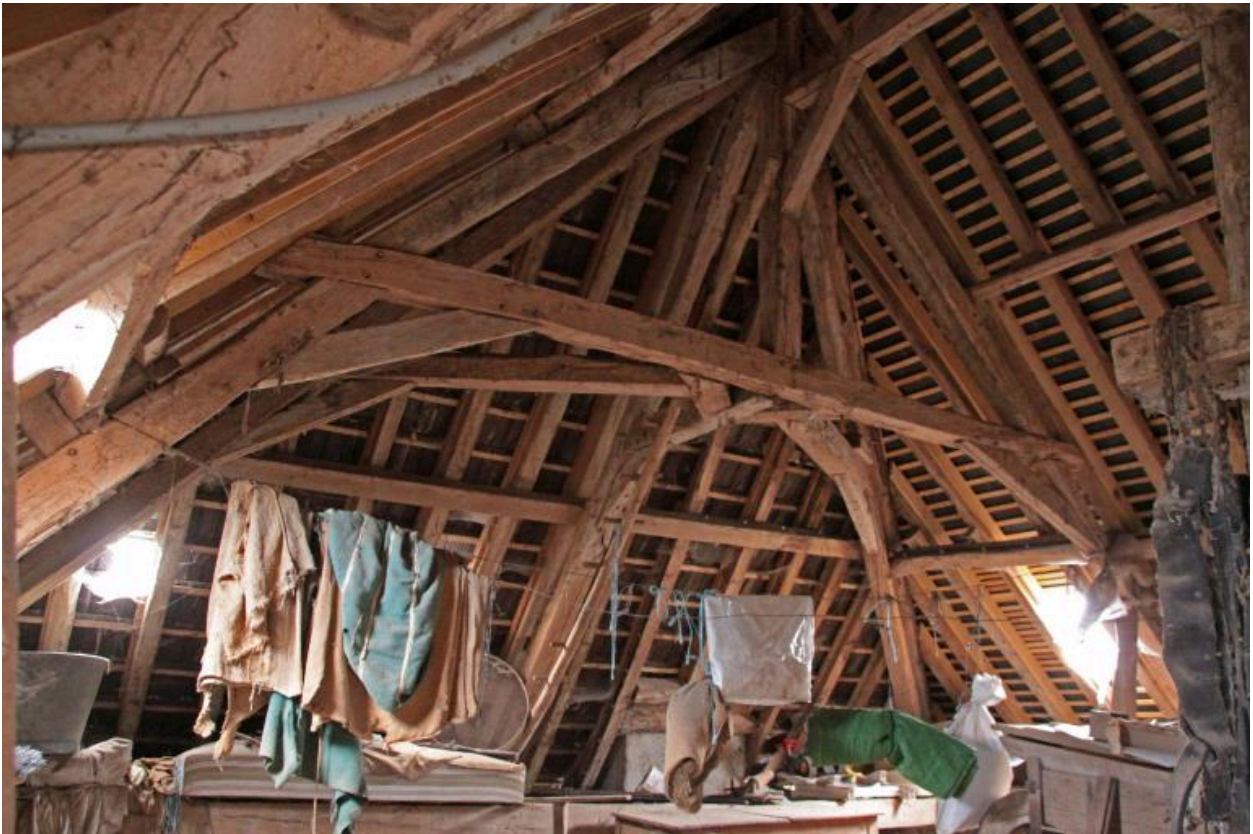
Maison, comble à surcroît : charpente (réemploi).
