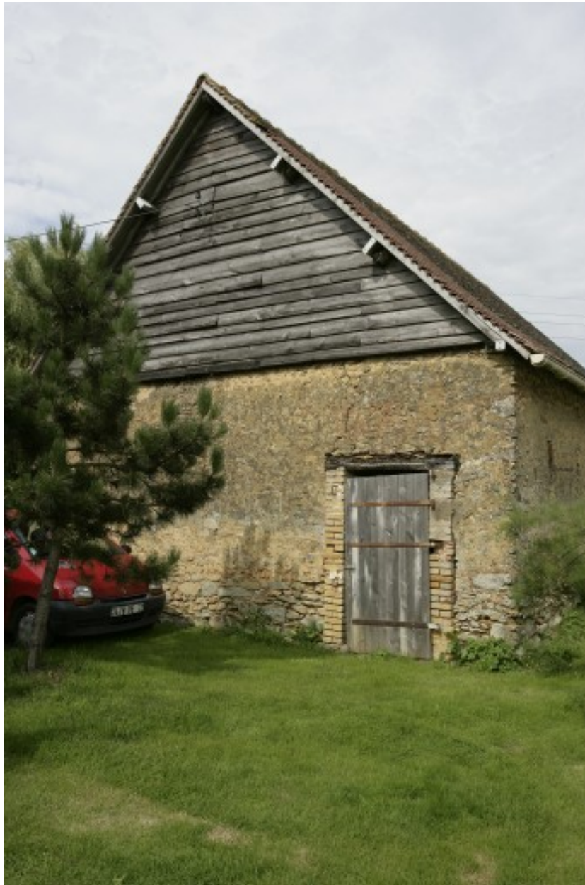
Étables, mur-pignon ouest.
