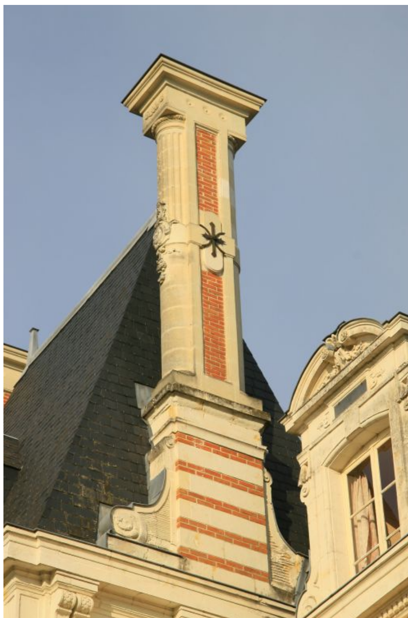
Façade antérieure : souche de cheminée dans une fausse lucarne.
