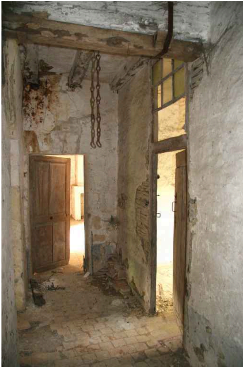
Sas du 1er étage vers la salle nord.
