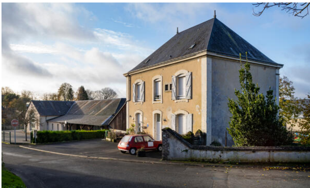
Elévation principale et mur-pignon.
