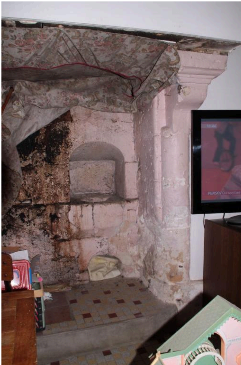
Chambre principale : piédroit droit de la cheminée et chauffe-plat.
