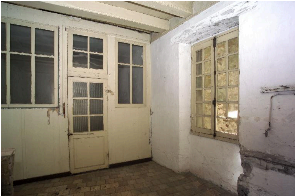
Le corps secondaire, premier étage, la première pièce.
