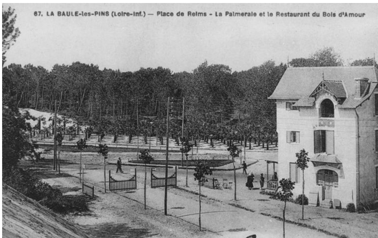
Palmeraie de la place de Reims et façade sud de la villa Souvenir.
