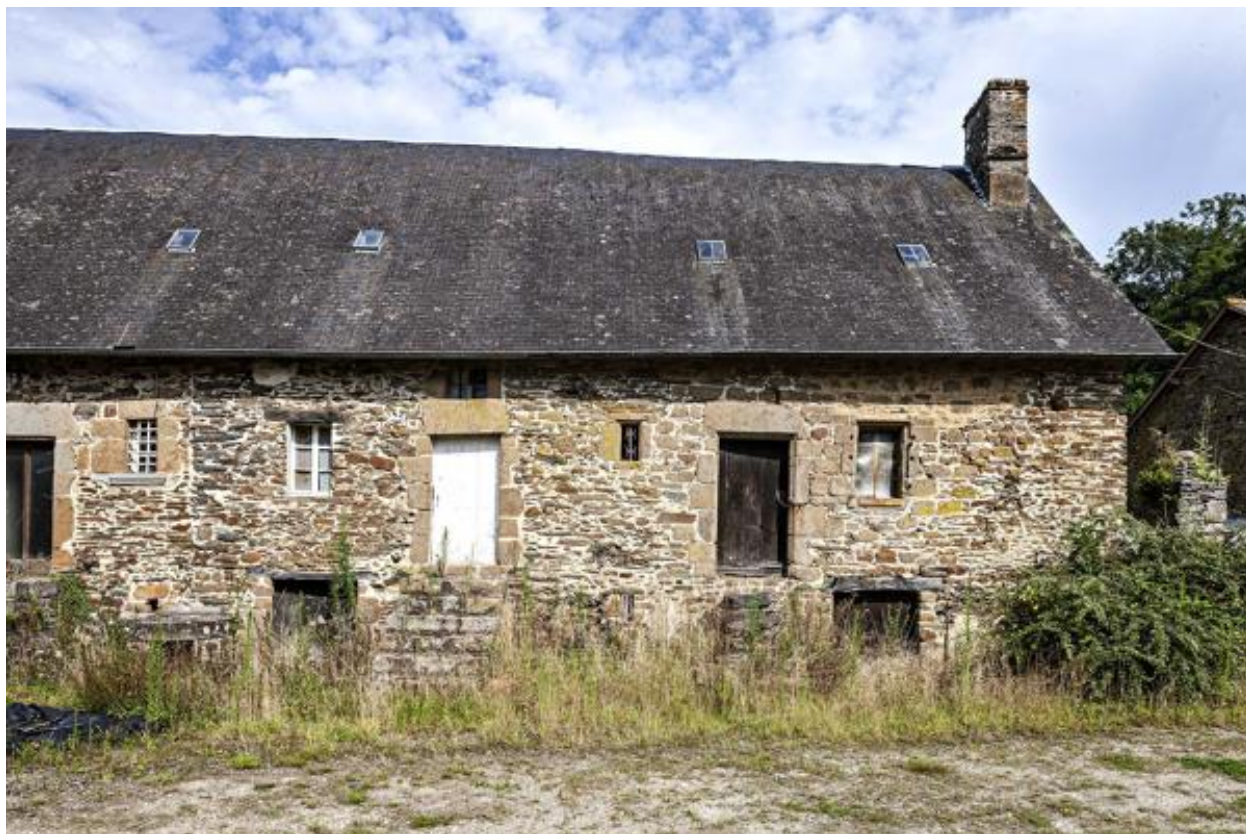
Corps de logis sud, partie nord.
