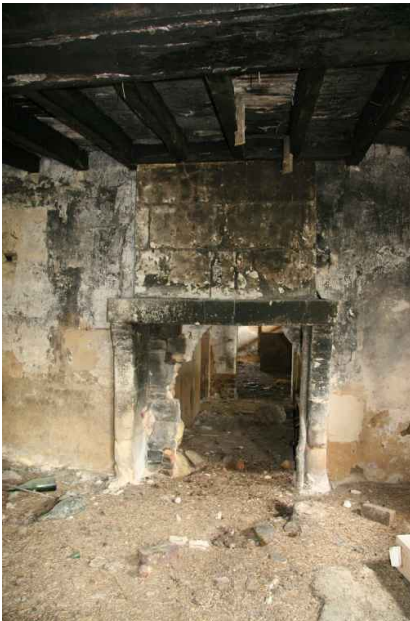
La chambre à feu : cheminée.
