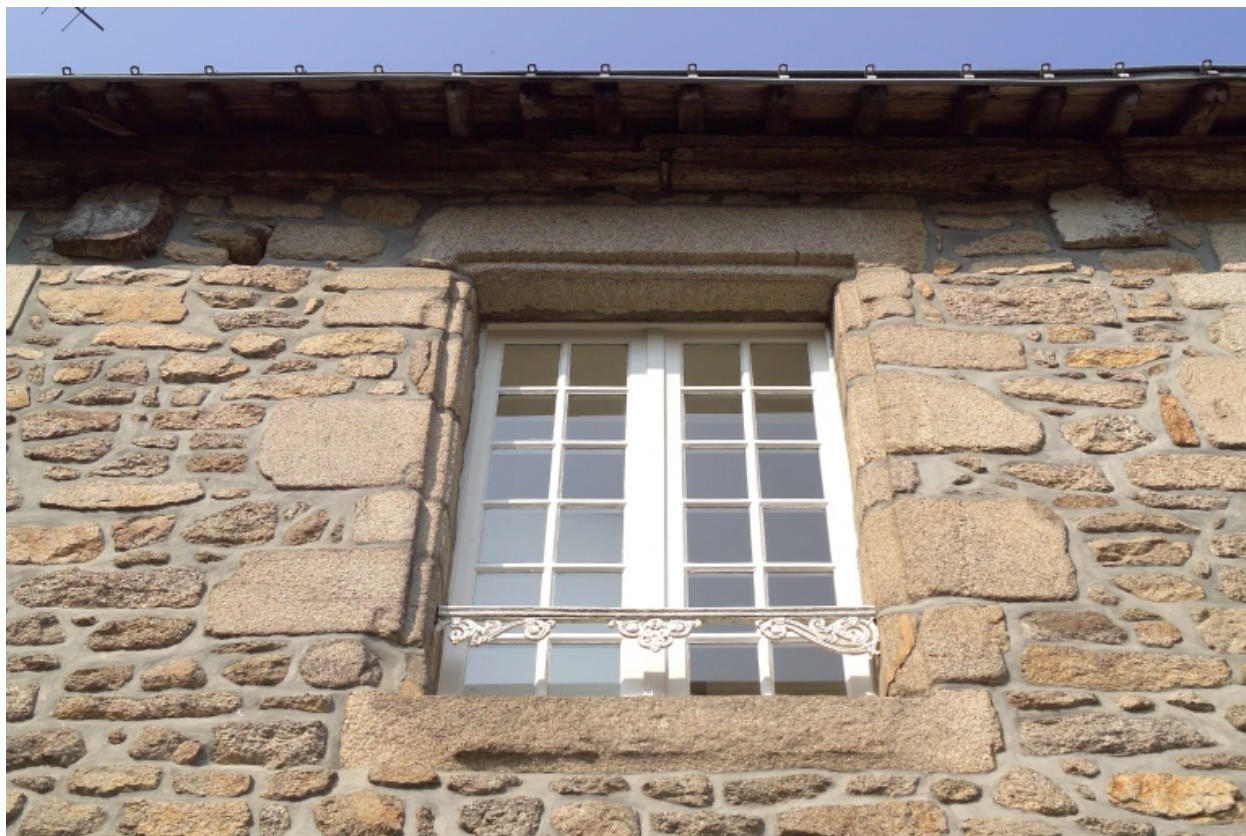
Détail d'une fenêtre sur la façade principale.
