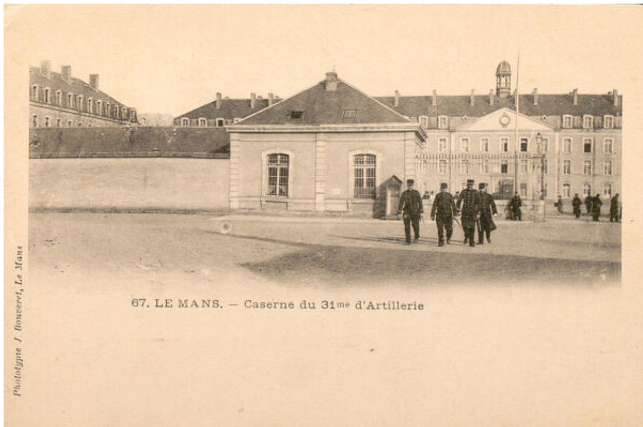
Vue de la caserne Paixhans au début du 20e siècle.
