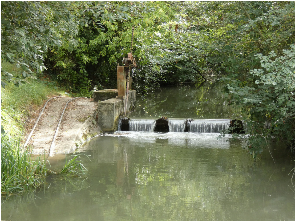
Le barrage vu depuis l'ouest.
