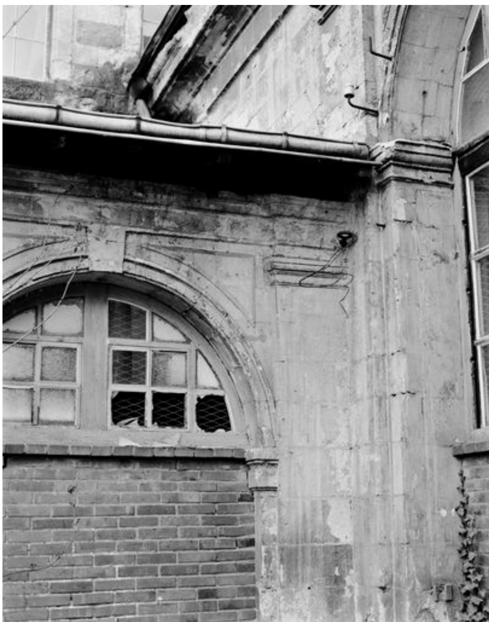
Abbaye, aile sud du cloître : façade nord, détail sur l'arcade d'angle à l'ouest.
