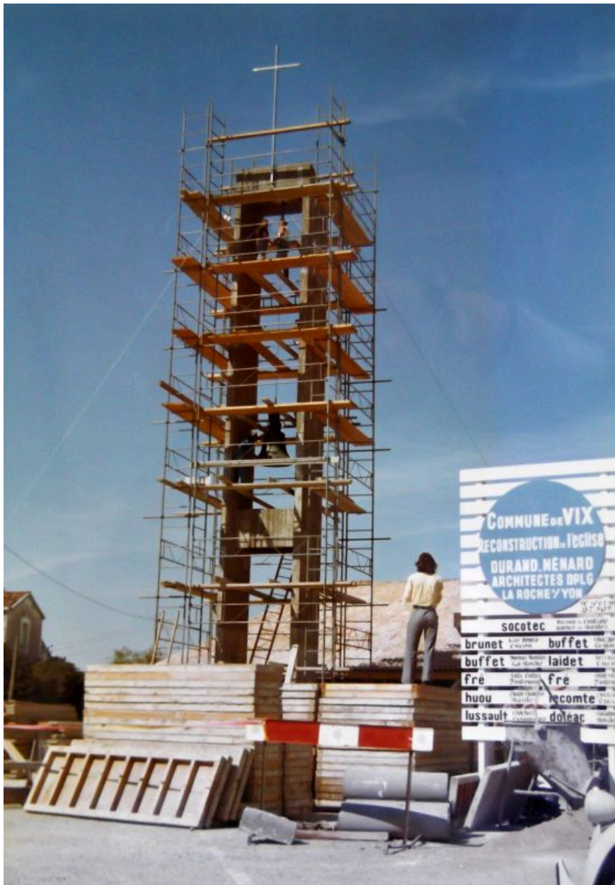
Pose des cloches dans le nouveau clocher, été 1974.
