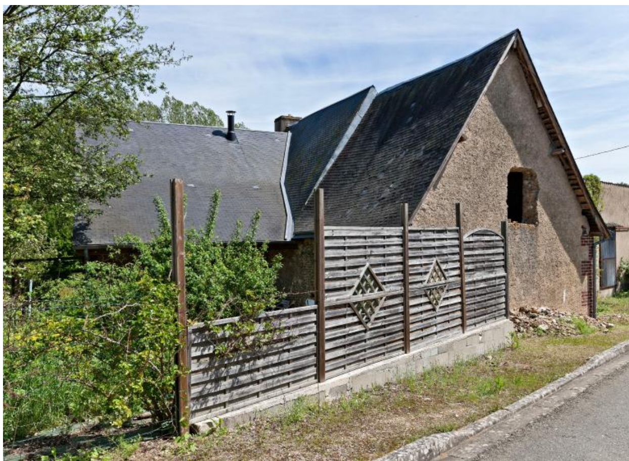
Bâtiment accolé au logis ancien ; à gauche, toiture de la meunerie.
