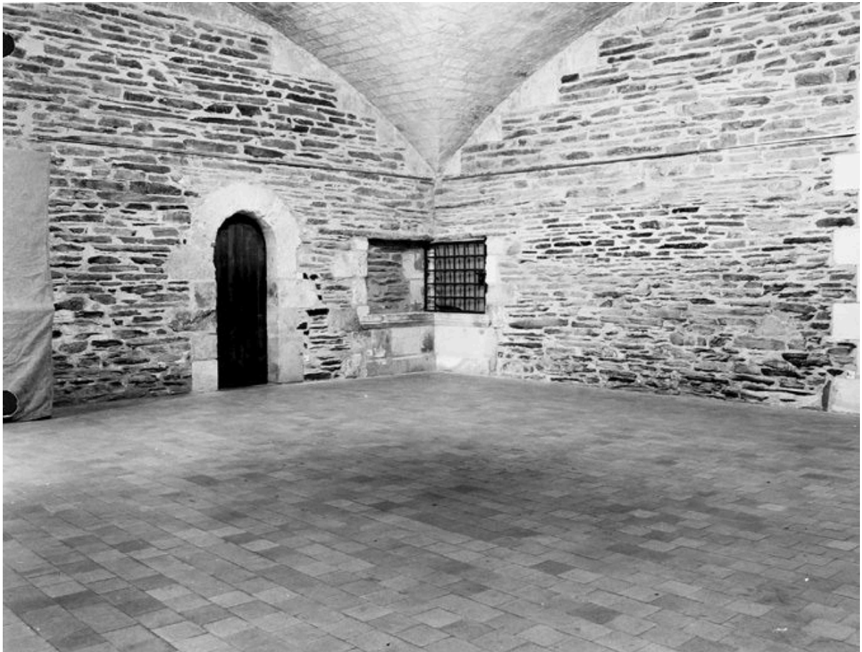
Tour-clocher dite tour Saint-Aubin, salle basse : angle sud- ouest.
