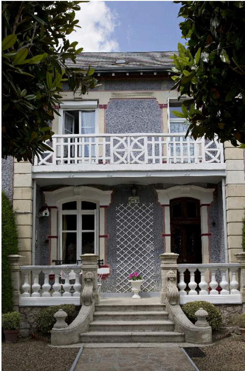
Façade côté rue : corps central.
