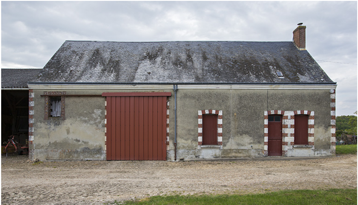
Ferme bloc à terre 2.
