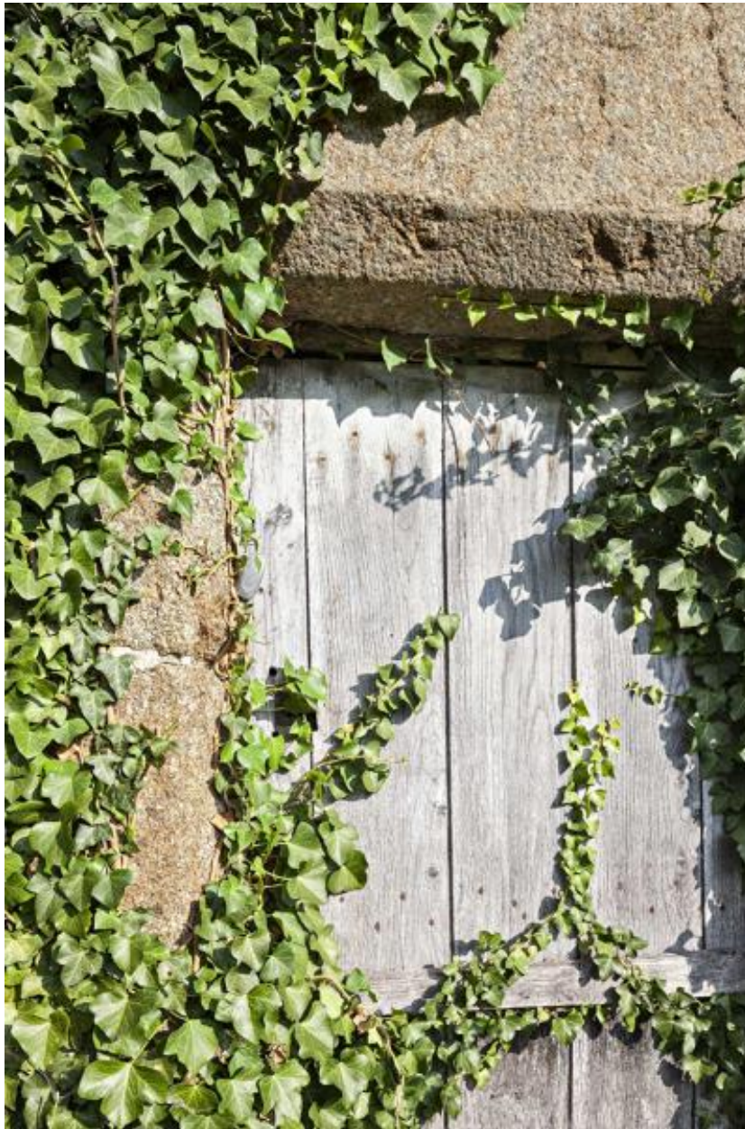
Ferme est, corps de logis central, détail de la porte chanfreinée.
