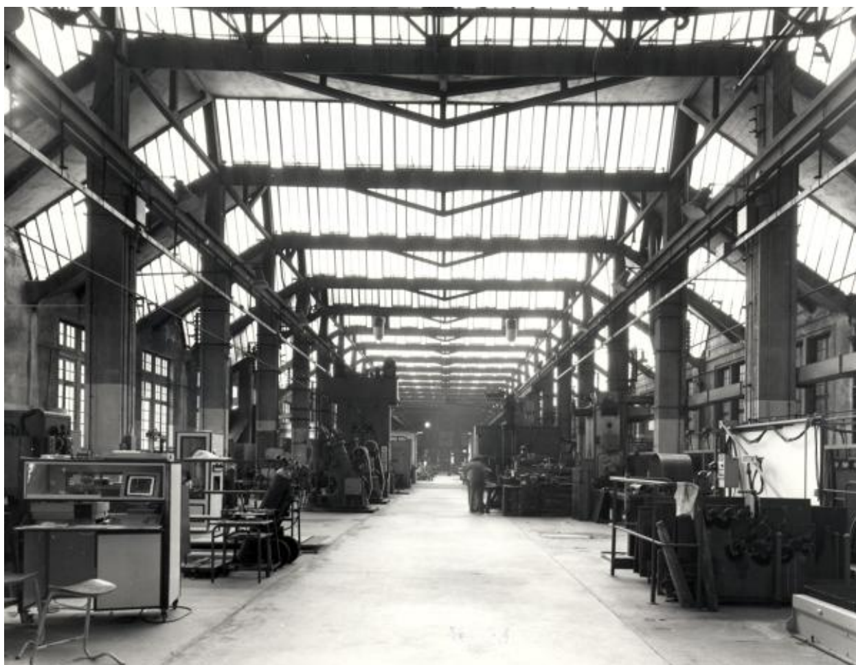
Forge et fonderie (par Bricard) : vue en axe longitudinal sud-nord.
