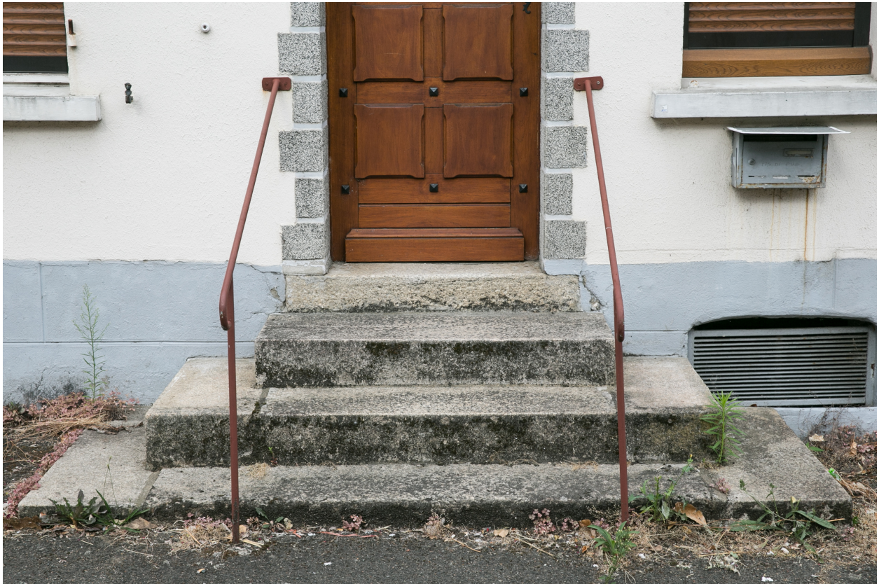
Un petit escalier extérieur (refait), rue Ledru-Rollin.
